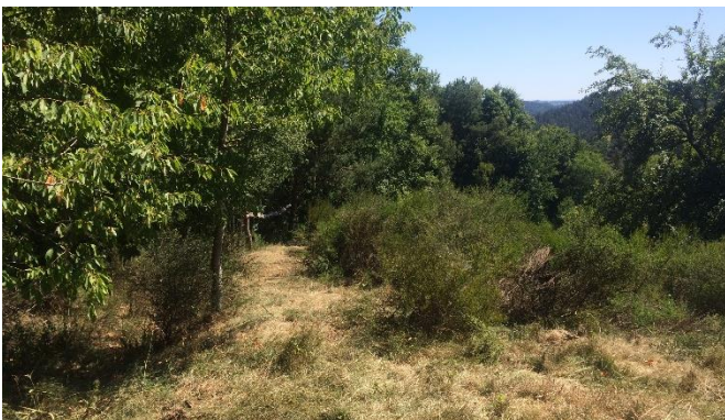
Die Zauntrasse nach der Fertigstellung. Foto: LEV
